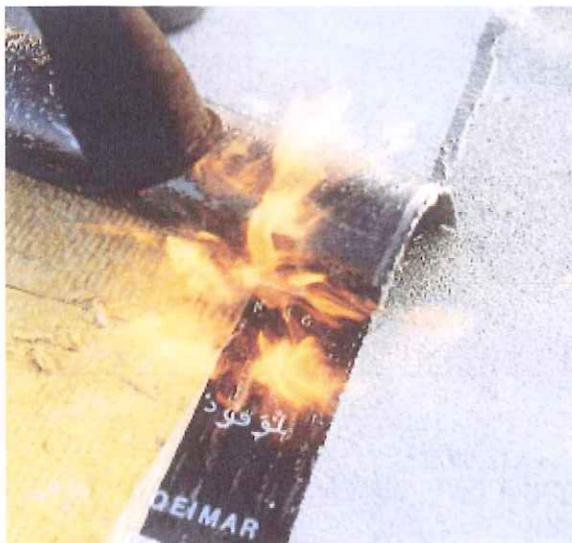
Kvalita natavení. AXTER má vyvinut jednoduchý srovnávací test s jasně definovaným a reprodukovatelným hodnocením. To ukazuje, že ALPA® výrobky ve srovnání s jinými modifikovanými pásy spotřebují při aplikaci méně energie, přitom mají nesrovnatelně vyšší adhezi k podkladu. Samozřejmostí je perfektní přilnavost a lepivost i při použití horkého vzduchu. Výjimečná jistota je i v perfektním plnoplošném spojení příčných i podélných spojů.
