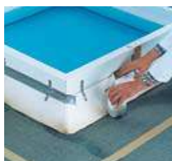
1 Přejíždění mezi světlíkem a sanovaným věncem se oblepí lepenkou.
