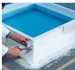
5 Roundo se zastříhne na rozích a Triflex ProDetail se ještě jednou natře v silné vrstvě.
