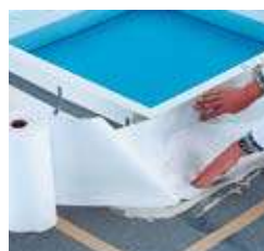
4 Triflex speciální roundo se položí na natřenou plochu bez bublin.
