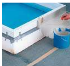
3 Triflex ProDetail se natře v silné vrstvě.
