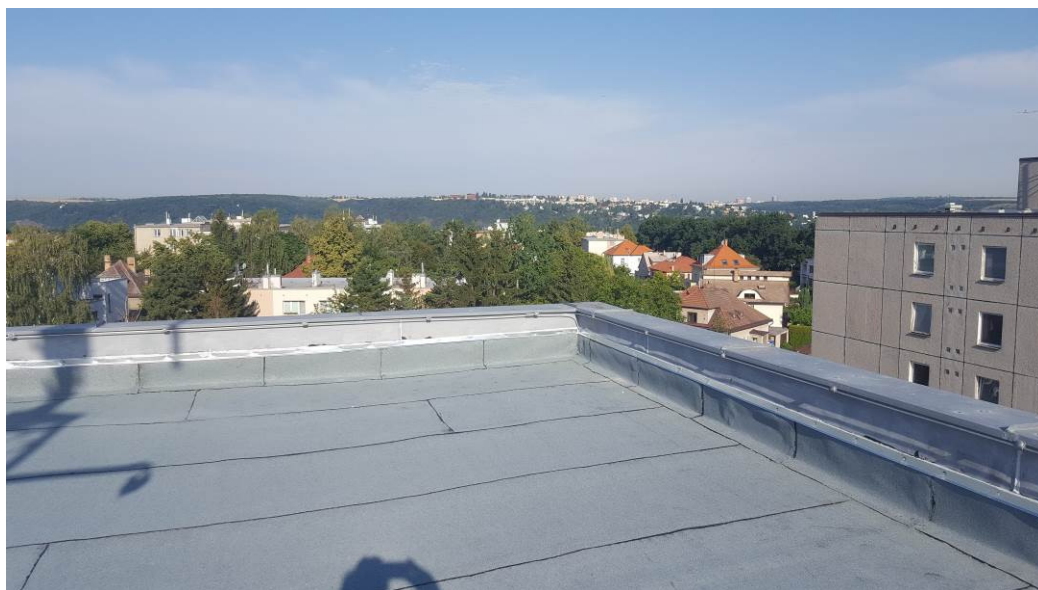
Obr. 4: Bytový dům v Praze. Oprava střechy pásy Alpal Decor CPV. (Archiv Grey s.r.o.)
