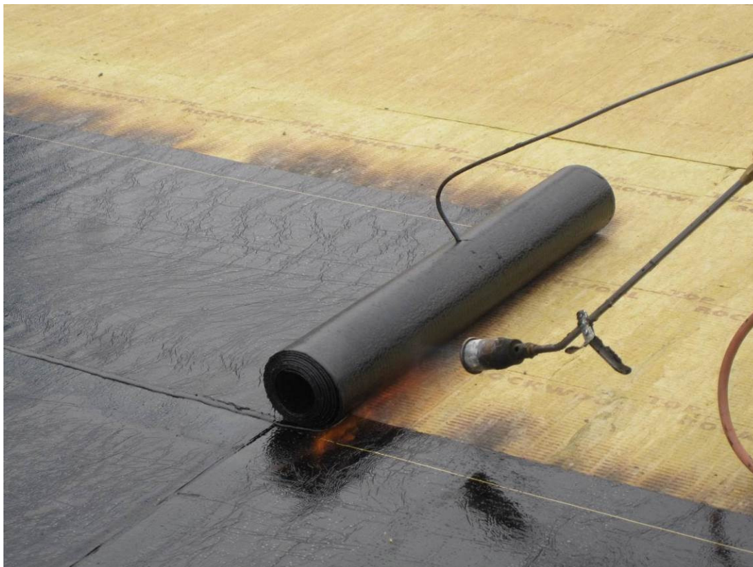
Obr. 7: Aplikace pásu Alpal 3000 Dalle na desku minerální vaty Rockwool Monrock E. (Archiv Hipos s.r.o.)
