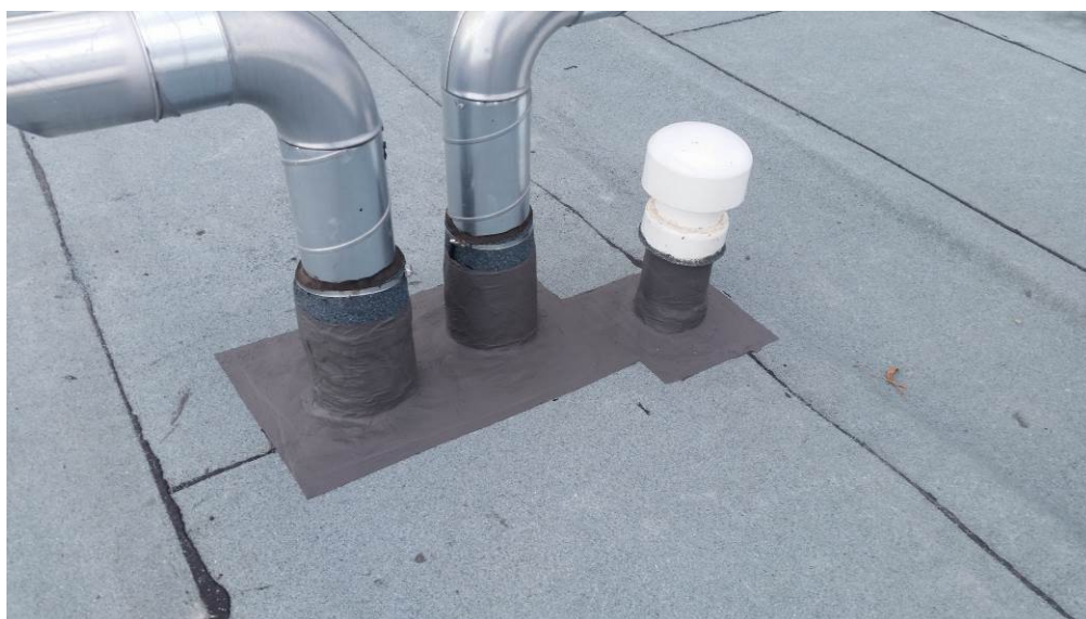
Obr. 3: Oprava střechy bytového domu v Praze pásy Alpal Decor CPV. Na posílení detailů je použit stěrkový systém Triflex ProDetail. (Archiv Grey s.r.o.)
