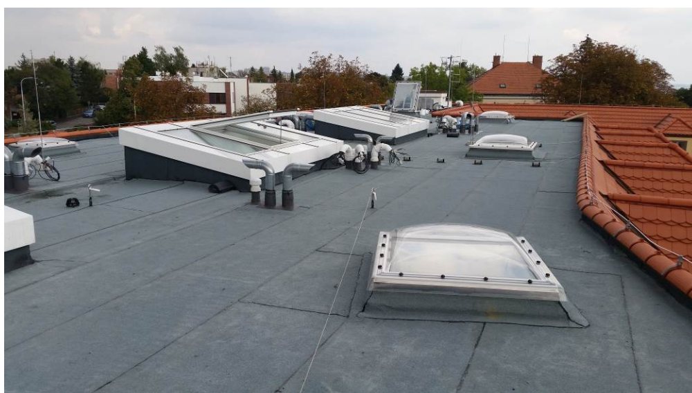
Obr. 2: Oprava střechy bytového domu v Praze pásy Alpal Decor CPV. (Archiv Grey s.r.o.)
