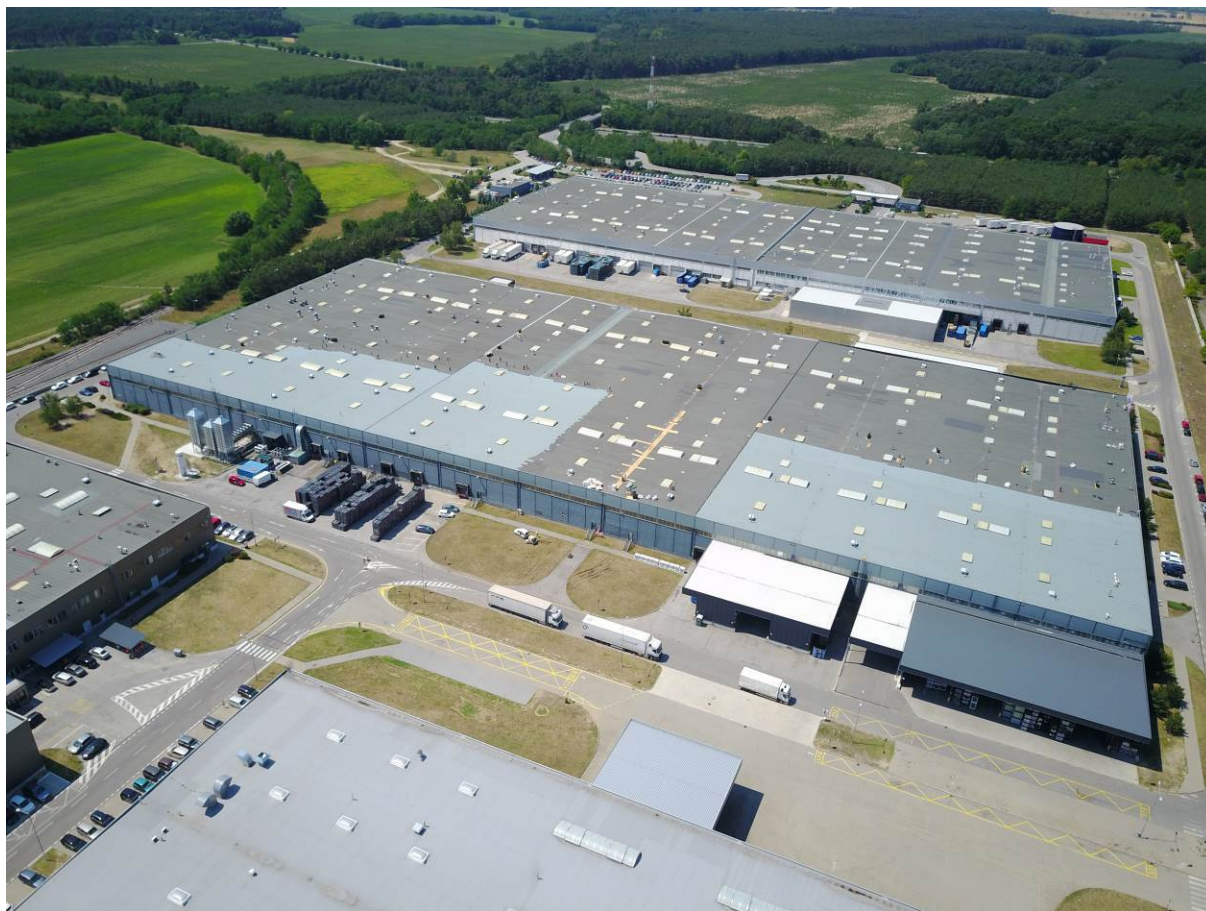
Obr. 1: Halový objekt u města Lozorno (Slovensko). Přivrstvování střešního pláště pásy Alpal 3000 S v průběhu realizace. (Archiv AXTER CZ s.r.o.)
