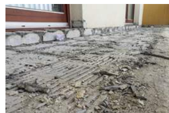
Demontáž keramické dlažby a stěrkové hmoty
