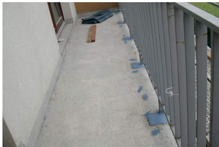
Příprava podkladu - vyspravení soklu a ošetření kotvení zábradlí
