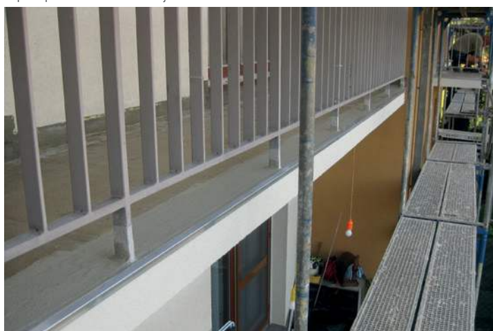
Výrovnání podkladu, penetrace, osazení okapnice, opravení sloupků pomocí detailové stěrky (Triflex ProDetail)
