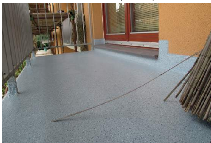
Nový stav balkónu se systémem Triflex BTS-P
