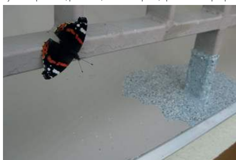
Bezpečné opravení sloupku zábradlí u okapní hrany lodžie
