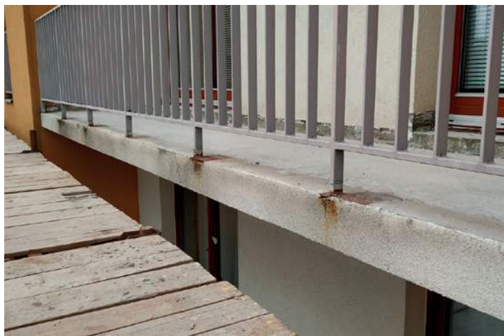
Příprava podkladu - zbrusnění desky
