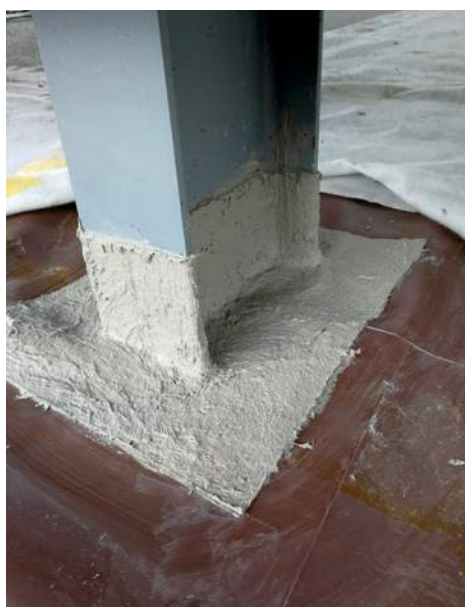
Prostup ocelového sloupu a foliové hydroizolační vrstvy, ProFibre, spodní stavba.
