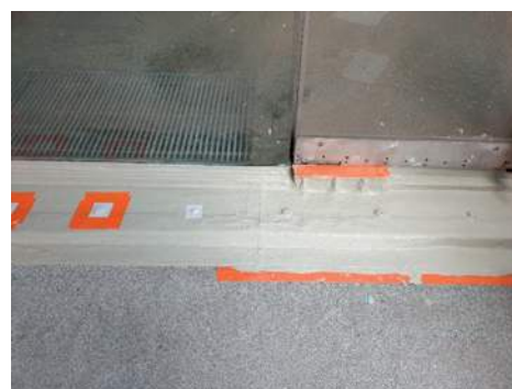
Návaznost hydroizolace z asfaltových pásů na prosklenou fasádu, opracování ProDetail, ProFibre v místě šroubů, kde není průběžná polyesterová rohož systému ProDetail – rozpracovaný detail, spodní stavba.
