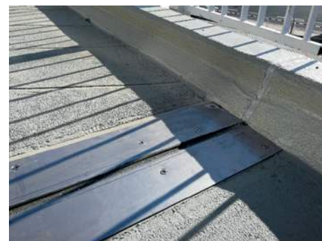
12) Pohled na rampu v místě dilatační spáry opatřené krycími profily, stav po sanaci.
