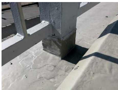
11) Opracování sloupku zábradlí, systém ProDetail a Cryl Finish 209, stav po sanaci.
