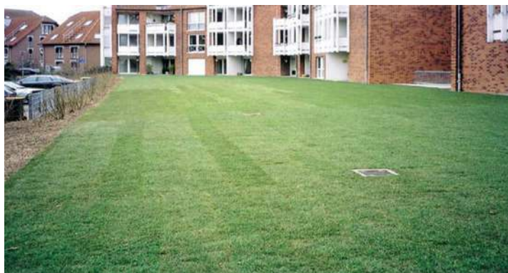
Obr. 2: Zelená střecha nad podzemními garážemi, Meerbusch u Düsseldorfu, systém ProDetail a ProTect (plocha), uvedení do provozu v roce 2002 (explicitně potvrzena bezvadná funkčnost do současnosti).
