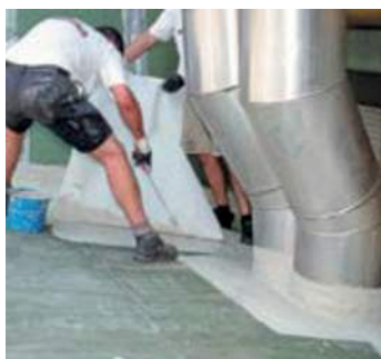
Obr. 1a: Střecha objektu pivovaru Diebels, Issum, systém ProDetail, uvedení do provozu v roce 2000, explicitně potvrzena bezvadná funkčnost do současnosti.
